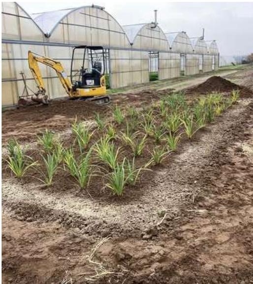
Agri-BioBed<sup>®</sup>, sviluppato da Bio Soil Expert, è un sistema filtrante di decontaminazione biologica che sfrutta piante e microrganismi per il confinamento, l'evaporazione e la degradazione dei principi attivi presenti nelle acque di risulta gestite nelle aziende agricole durante i trattamenti fitoiatrici.
